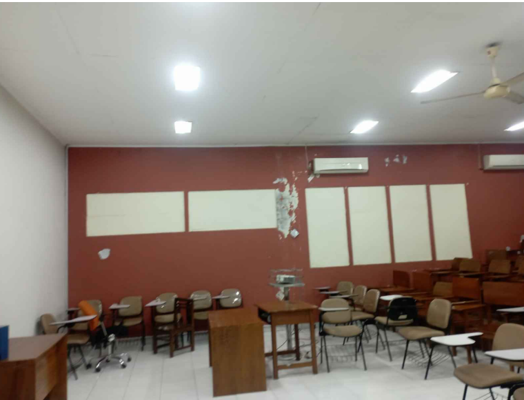
KONDISI EXISTING Skala :NTSC
