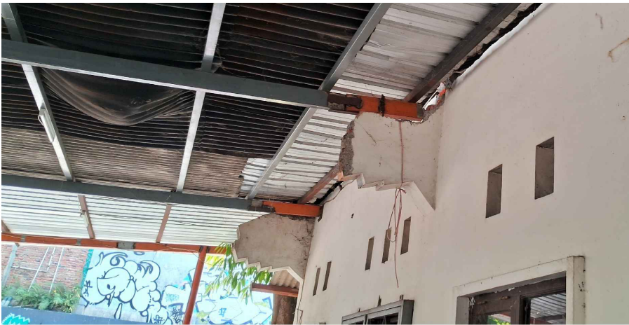
KONDISI KONSOL KANTIN YANG AKAN DIBONGKAR
