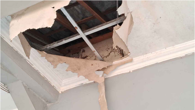
KONDISI EXISTING SKALA NTSC
