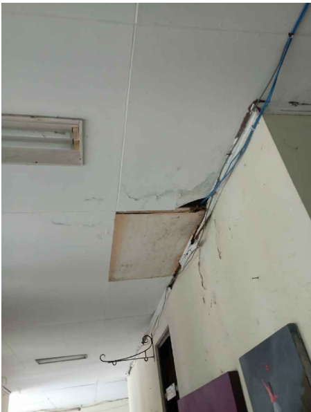
KONDISI EXISTING Skala :NTSC
