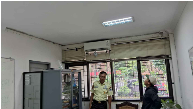
KONDISI EXISTING Skala :NTSC
