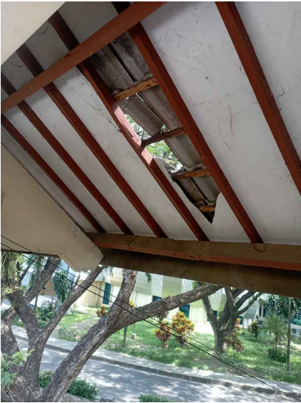
KONDISI EXISTING Skala :NTSC
