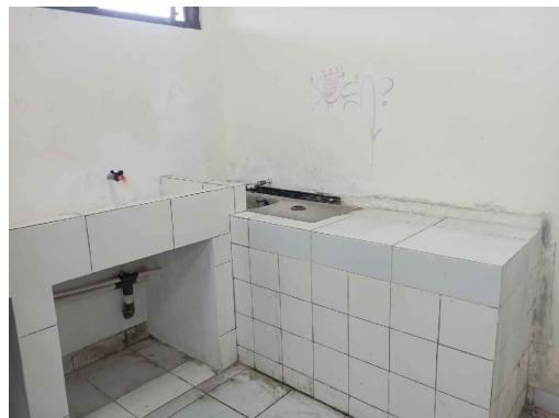
KONDISI EXISTING Skala :NTSC
