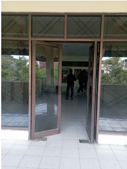
KONDISI EXISTING Skala :NTSC
