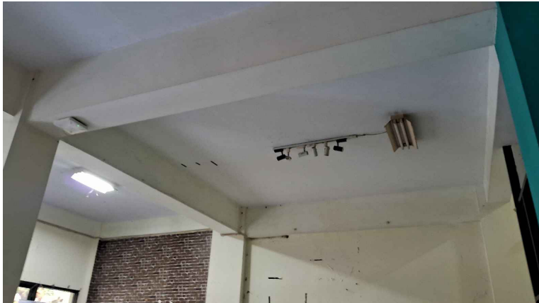
KONDISI EXISTING SKALA :NTSC
