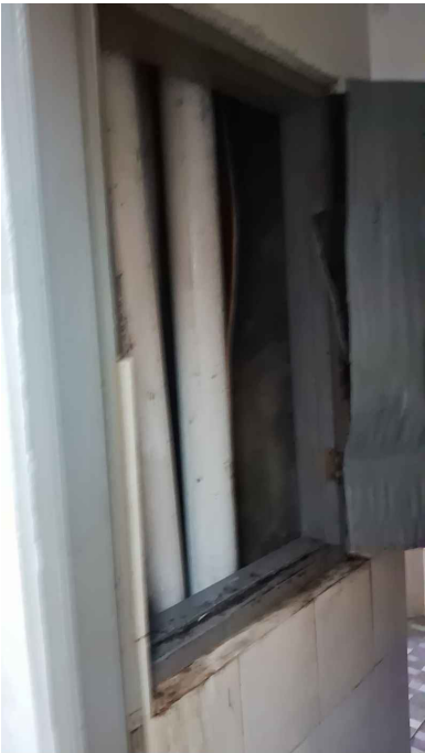
KONDISI EXISTING SKALA : NTSC
