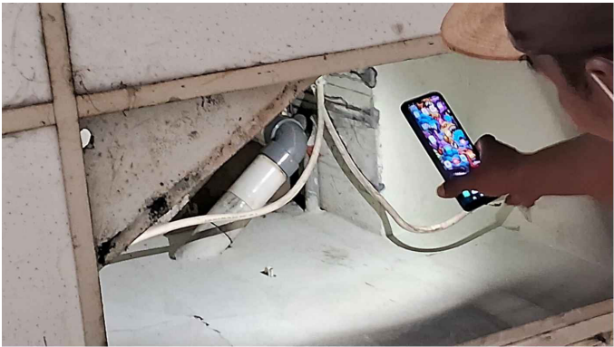
KONDISI EXISTING Skala :NTSC
