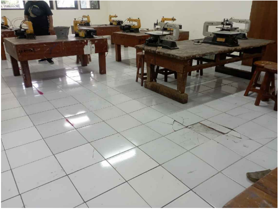
KONDISI EXISTING Skala :NTSC
