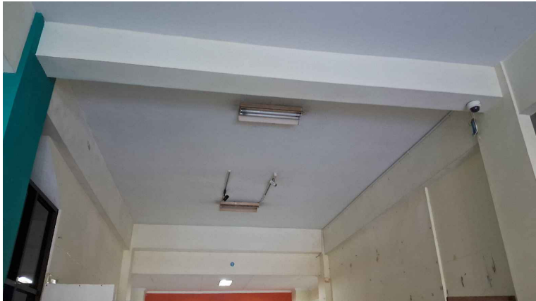
KONDISI EXISTING SKALA :NTSC
