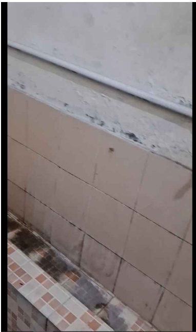
KONDISI EXISTING Skala :NTSC
