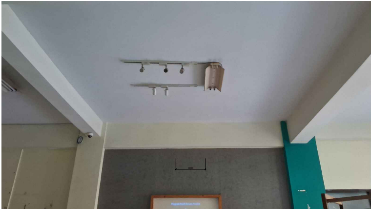
KONDISI EXISTING SKALA :NTSC
