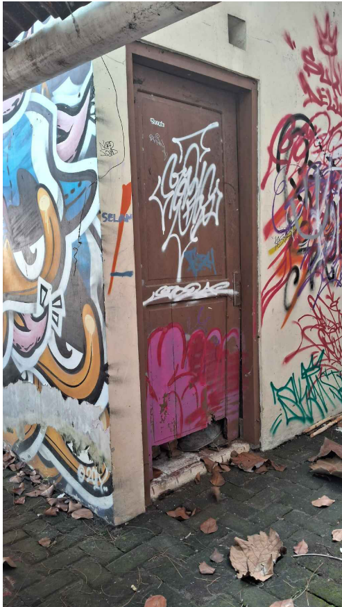
KONDISI PINTU YANG AKAN DITUTUP
