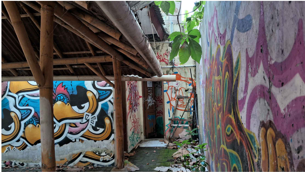
KONDISI LAHAN PEMBANGUNAN TOILET
