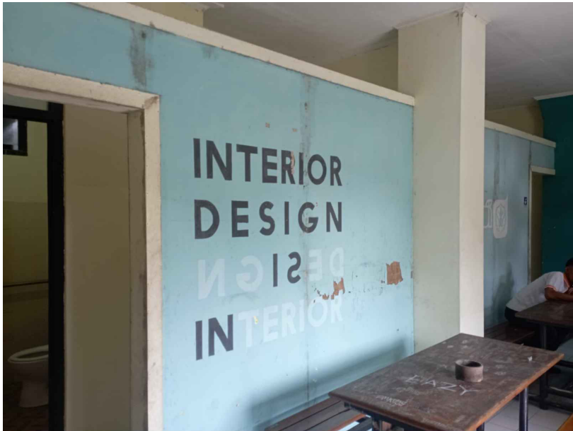
KONDISI EXISTING Skala :NTSC
