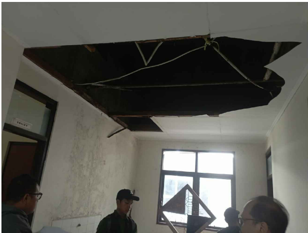
KONDISI EXISTING Skala :NTSC
