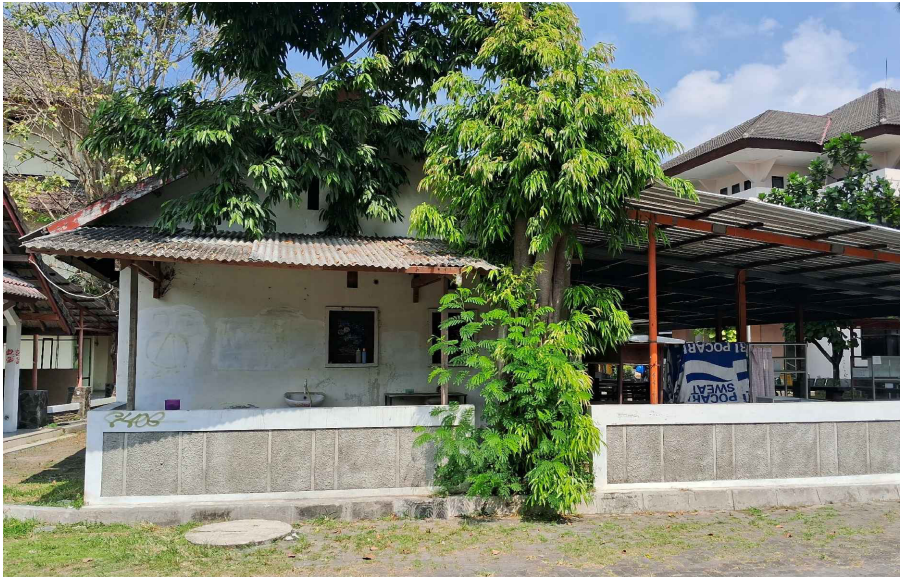
KONDISI KANTIN YANG AKAN DIPASANG ROSTER BARU
