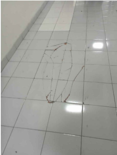
KONDISI EXISTING Skala :NTSC
