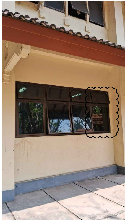
KONDISI EXISTING SKALA NTSC
