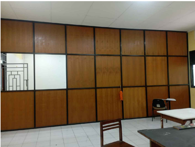
KONDISI EXISTING Skala :NTSC
