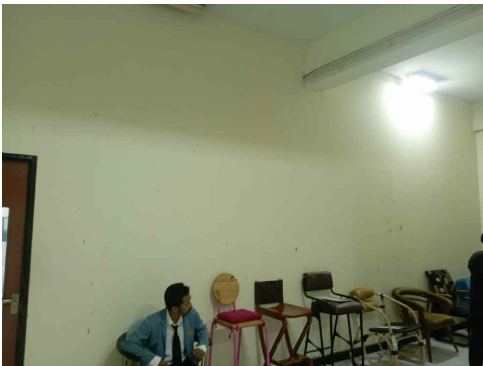
KONDISI EXISTING Skala :NTSC
