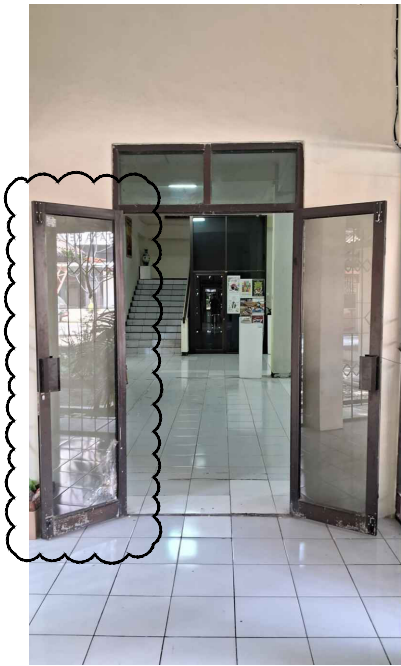
KONDISI EXISTING SKALA NTSC
